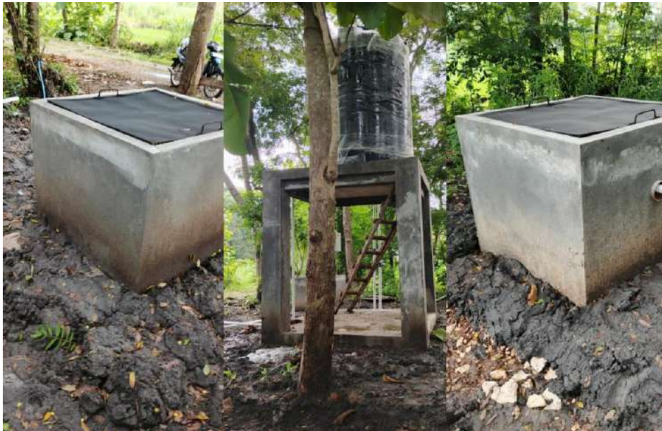
Gambar 3. 26 Pembangunan Sumur DBHCHT 2025
